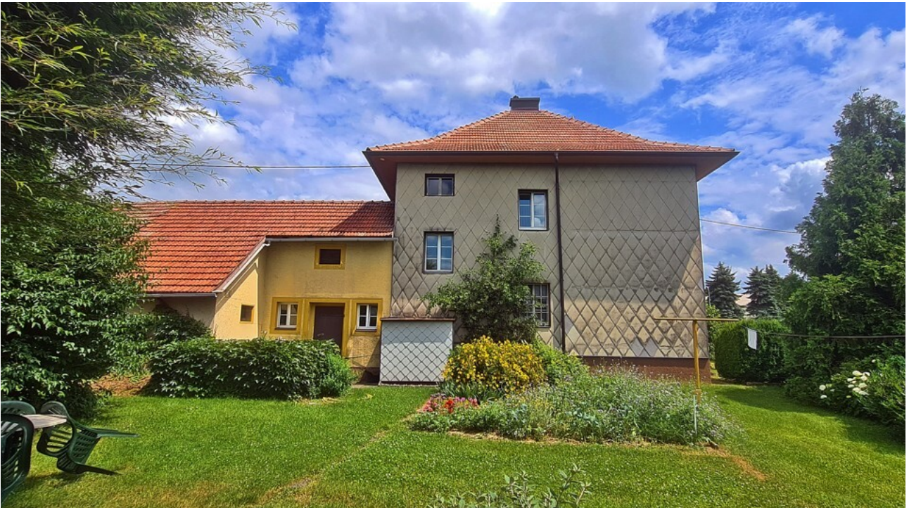
Westansicht mit Gartenteil
