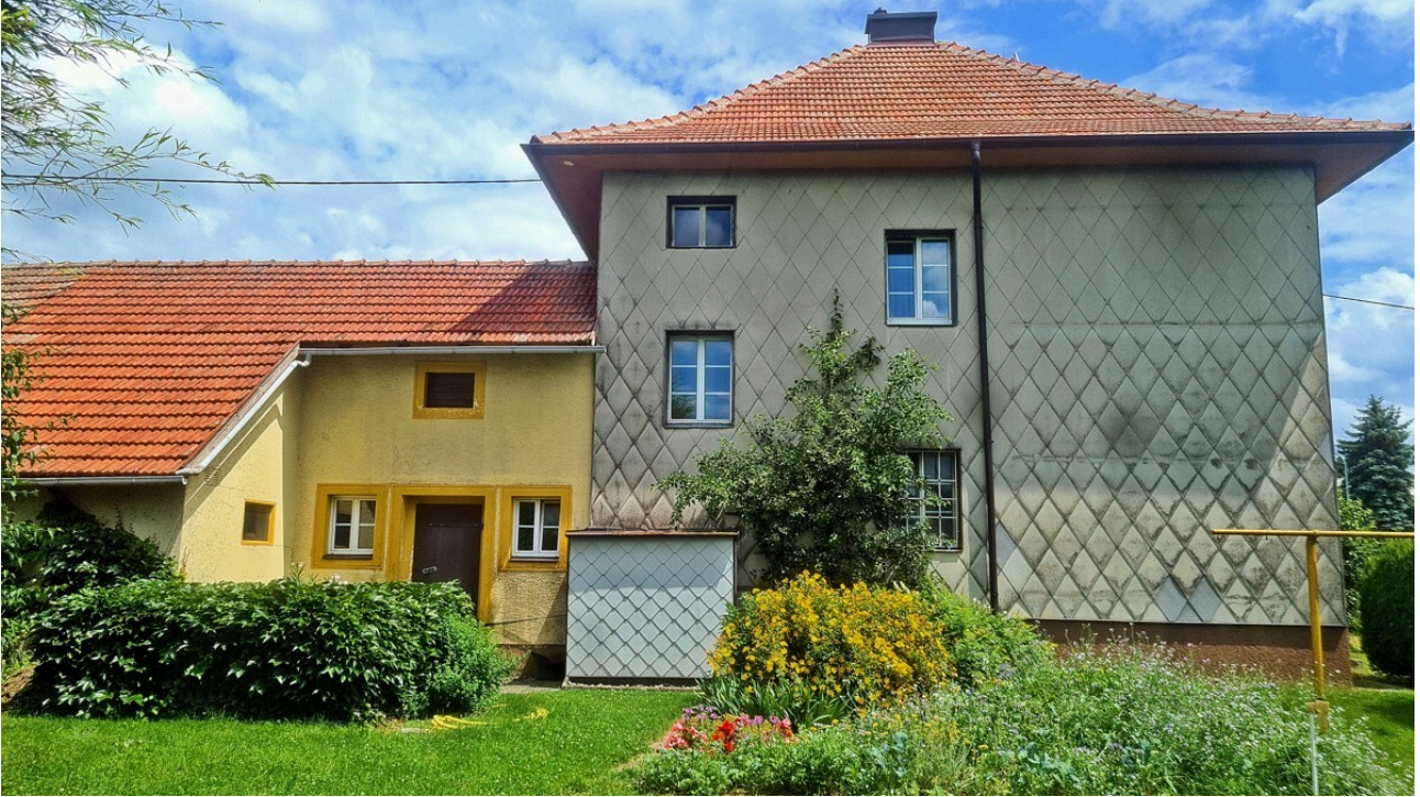
Westansicht mit Gartenteil
